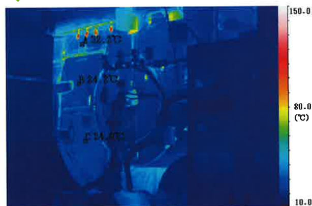
サーモジャケット施工後の赤外線カメラ熱画像
